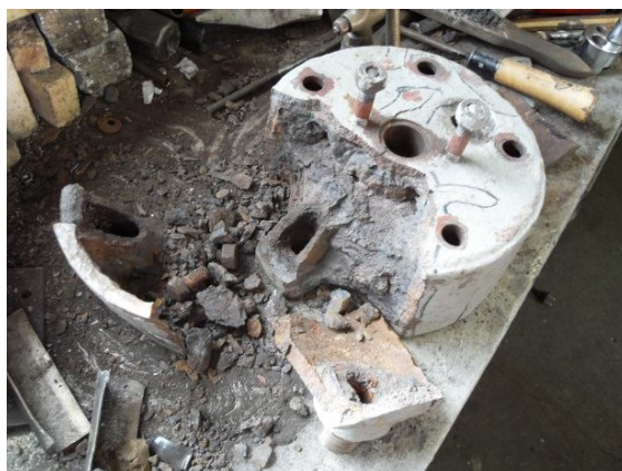
Topplukk var i meget dårlig stand
