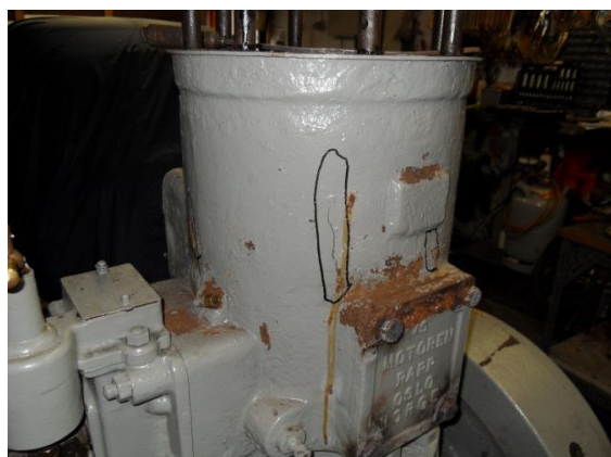
Ut boring vannkappe
